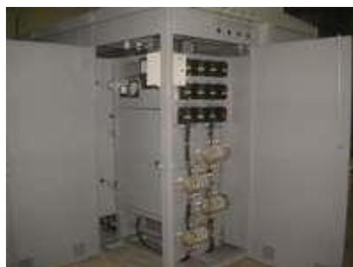
Подстанции предназначены для приема, преобразования и распределения электрической энергии трехфазного переменного тока частоты 50 Гц напряжением до 10 кВ
